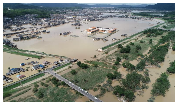
図 1 平成 30 年 7 月豪雨小田川決壊の様子 (1)
